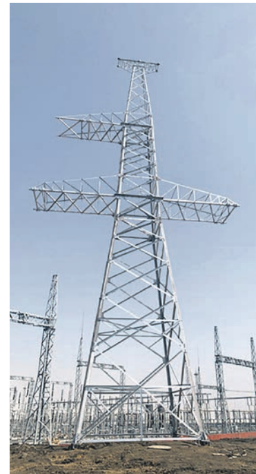
△ Детали сложились в опоры © АРХИВ ОМК
